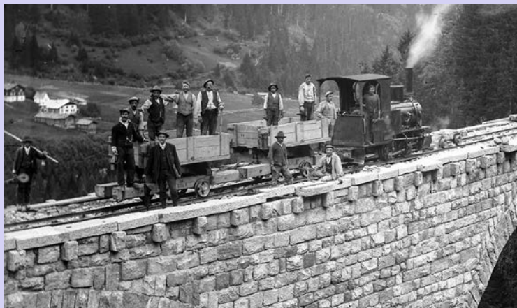
Rhätische Bahn (Russeinerbrücke).
