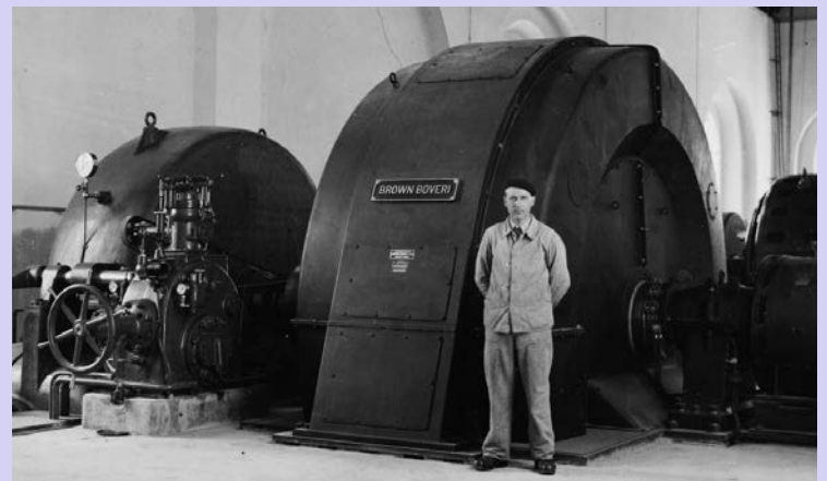
Kraftwerke Brusio (heute Repower AG).
